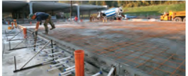
Die Benutzung der Ideal Fuge 70 cm tief erlaubt die strukturellen Platten und den darüberliegenden Boden innerhalb von 12-16 Stunden mit zwei separaten "nass auf nass" Güssen zu machen, dadurch erhalten einzelne Platten strukturelle Leistung. Die Dicke der Platten kann deshalb reduziert werden, da das System eine monolithische Leistung gewährleistet, während es zur gleichen Zeit eine hohe Qualität und ästhetischen Standard bis zum totalen Fehlen von Makro- oder Mikrorissen bietet.
