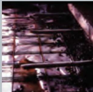
Beispiel einer falschen Herstellung einer Betonierfuge
