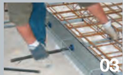
Installation der Plastikhülsen und Dübelstangen
