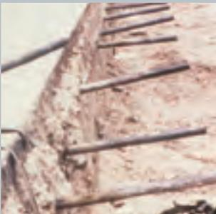
Fehlende Ausrichtung der Betonierfuge mit unvollständiger Schalung
