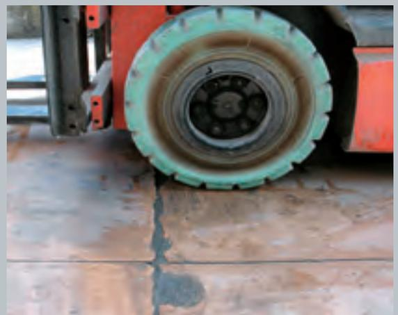
Beispiel einer beschädigten Betonierfuge nach einigen Monaten.
